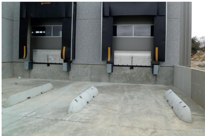
Pont de chargement articulé en profilé aluminium avec zone de refuge de 500 mm répondant à la norme NF EN 349.
